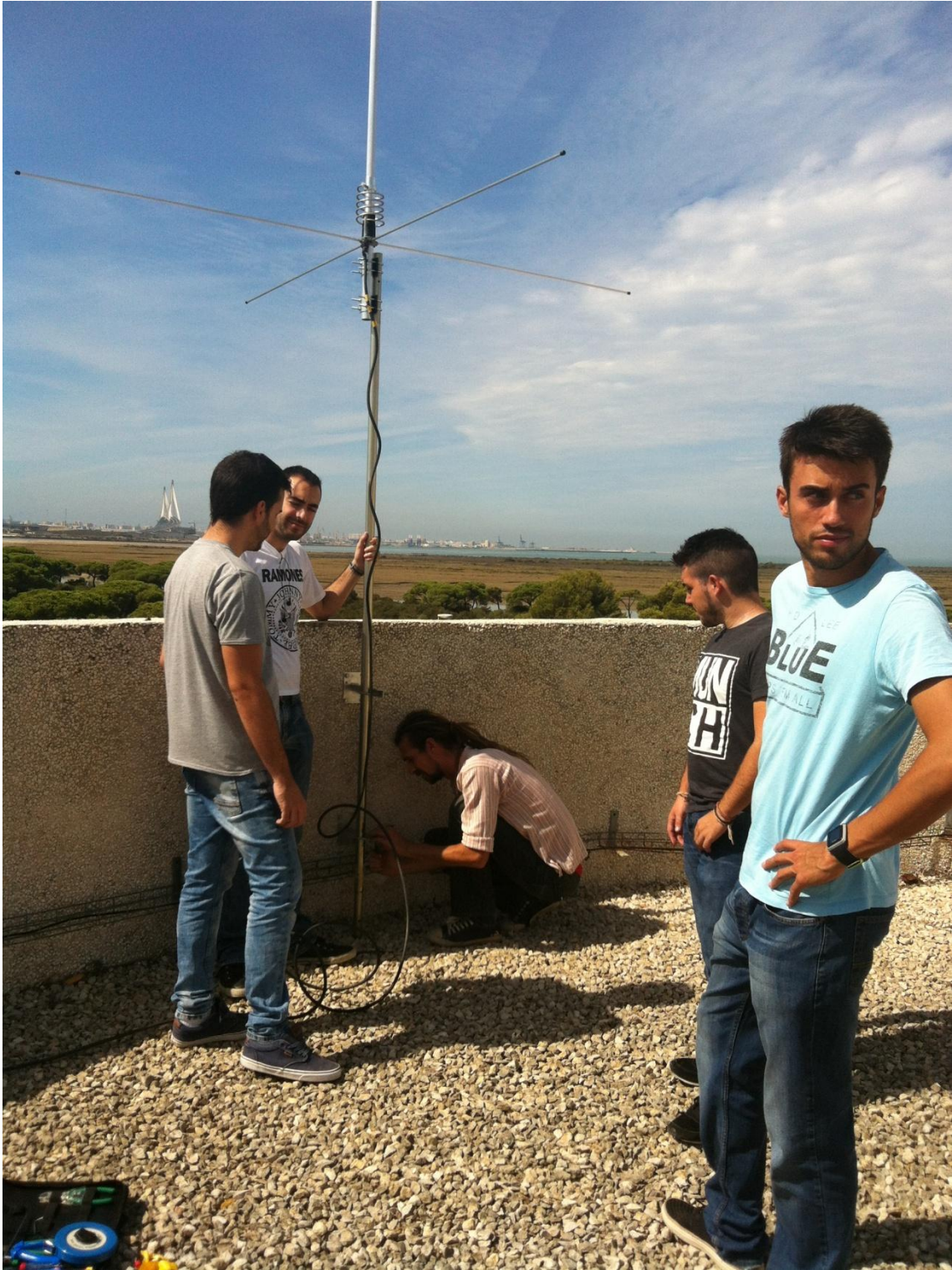
Instalación final en el Campo de Antenas de la Pala A.
