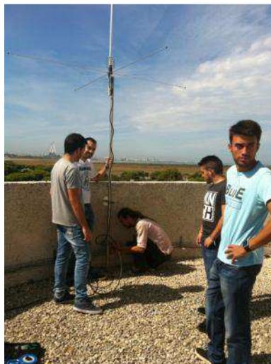
Una vez comprobada la estabilidad del montaje, procedemos a atornillarla al mástil mediante unas garras de sujeción metálicas. Posteriormente del montaje, la sujetamos al mástil, atornillamos el último radial y la fijamos a la pared. Finalmente conectamos el cable coaxial (RG-58) a la conexión de la antena (LI 259), tras lo cual estará lista para su funcionamiento en OC.
