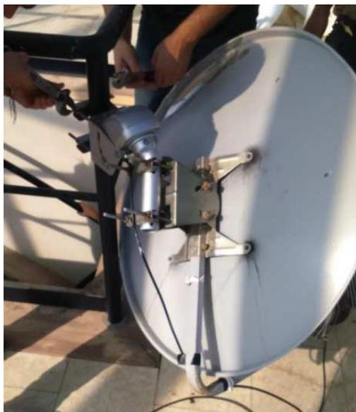
Una vez instalada la nueva antena, al igual que en prácticas anteriores, procedemos a realizar la conexión en el otro extremo del cable el cual irá conectado al receptor correspondiente, en este caso un receptor RTL-SDR para la aplicación de UCA Marconi.
