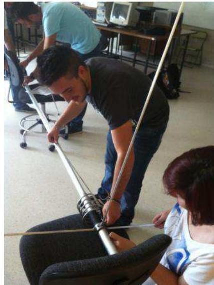
Una vez tenemos la antena montada y todas las partes identificadas, procedemos a desmontarlas en partes que resulten manejables para poder transportarlas has la azotea del CASEM. Aquí se busco un punto adecuado que no interfiriera con el resto de antenas y cercano a la conexión existente. Se procedió al montaje definitivo de las secciones y mediante una cinta métrica se adaptó a la longitud requerida, en este caso de 6,60 metros.
