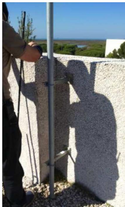
Una vez desmontado el mástil, se procede al montaje de la nueva antena y a la reposición de las baterías de la estación meteorológica y su limpieza. Debido a la complejidad de los trabajos de instalación y mantenimiento de antenas dada la forma de éstas, esta labor resulta más cómoda cuando se cuenta con ayuda suficiente para el manejo.
