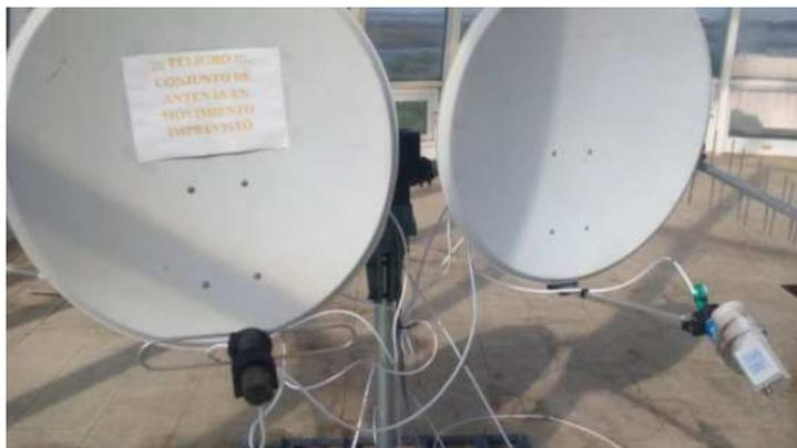
Una vez que tenemos fijada la antena en su soporte y en su posición definitiva (en este caso, ambas antenas se han colocado con polarización horizontal), comprobamos que el cable no tiene ningún dobléz o vuelta indeseada. Pasamos a instalar el conector en el otro extremo del cable y a comprobar la impedancia del cable en el extremo inferior, el cual debería de presentar una impedancia muy baja.
